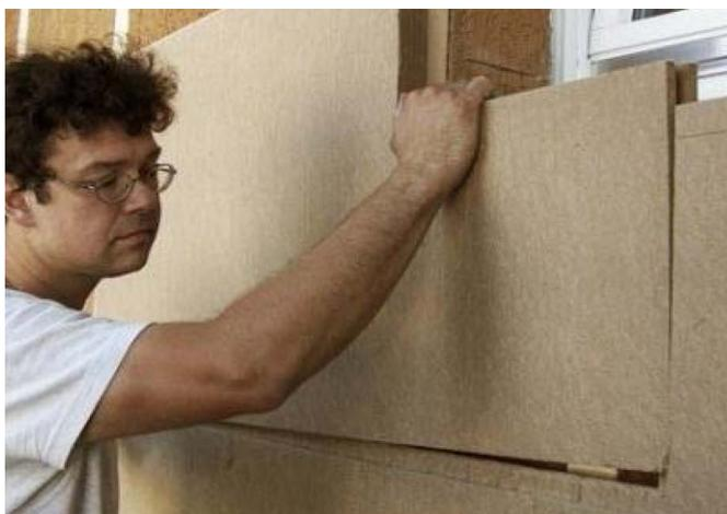
I tasselli certificati ETAG devono essere concepiti specificatamente per sistemi a cappotto termico e la tipologia varia a seconda del tipo di supporto. I tasselli vanno applicati dopo l'indurimento della malta, in numero variabile in funzione delle caratteristiche del supporto, dell'altezza dell'edificio e degli agenti atmosferici. Lo schema di fissaggio prevede due varianti: a T e a W. Prevedere circa 7 tasselli a metro quadrato.
