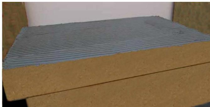
In entrambi i casi, la malta non deve essere applicata sulla superficie laterale del pannello, per garantire la continuità e la perfetta aderenza dell'isolamento ed evitare l'insorgenza di ponti termici. Affinché l'incollaggio sia efficace, è necessario che il collante-rasante penetri tra le fibre superficiali del pannello.
